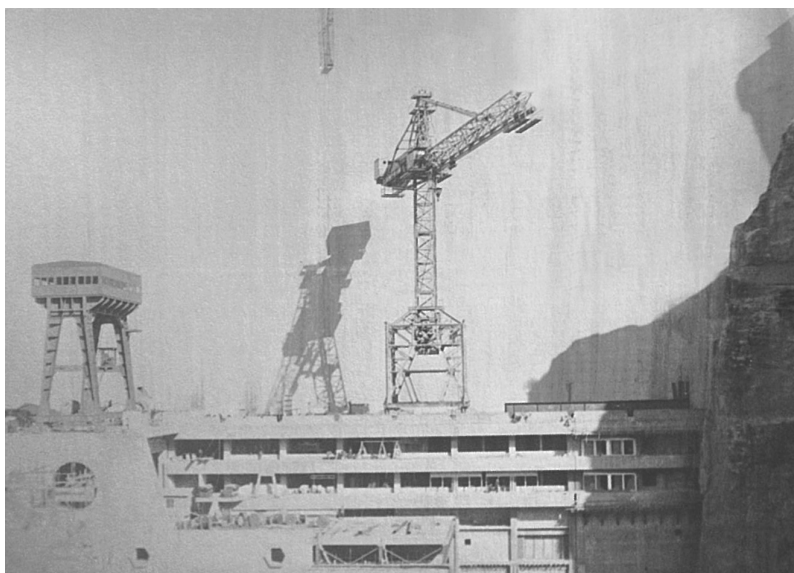
Будівництво ГЕС у Дакані
