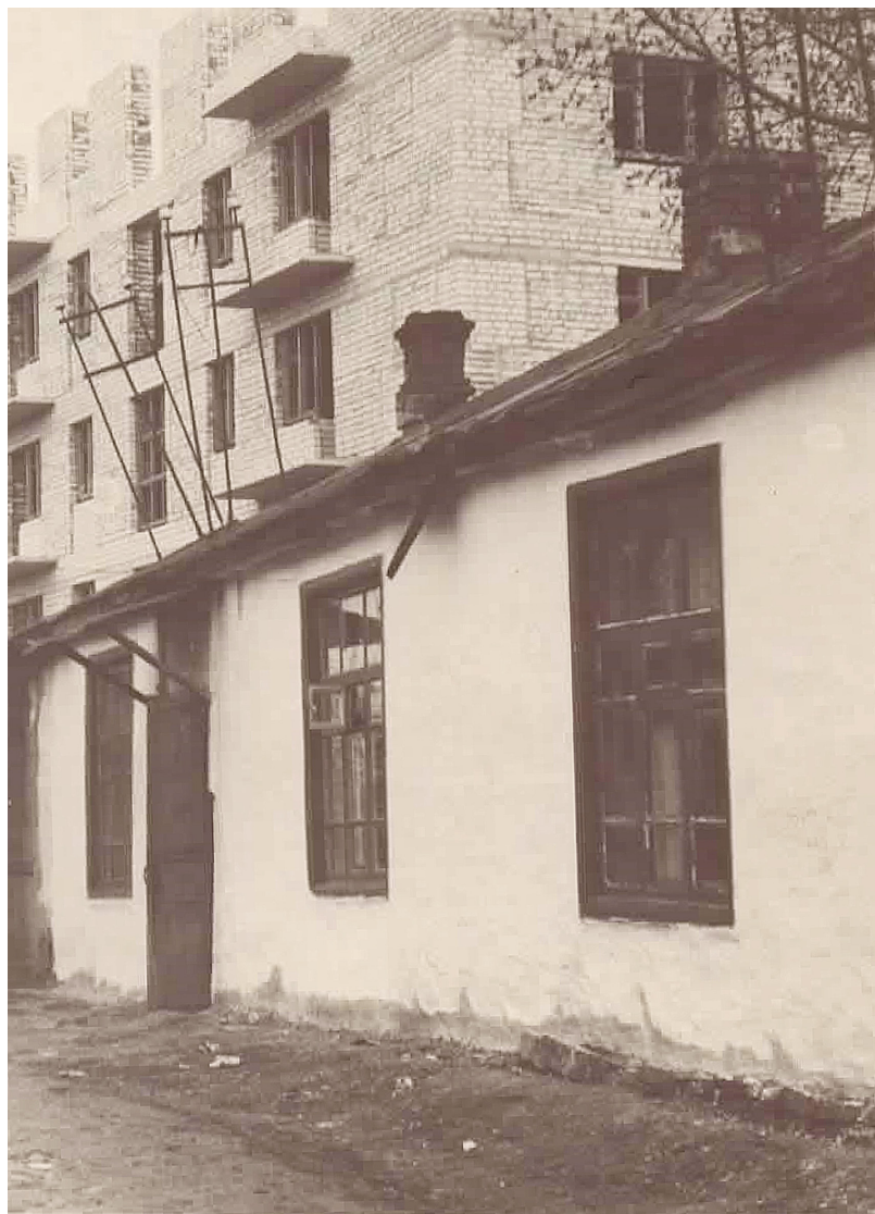
на вул. Тимірязєва. 1986 р.
