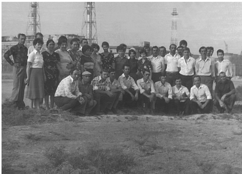
Будівельники СУ-2, СУ-3, СУ-1
