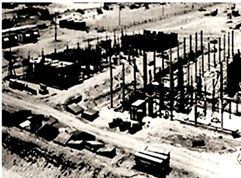
Початок будівництва ТЕС в Адені
