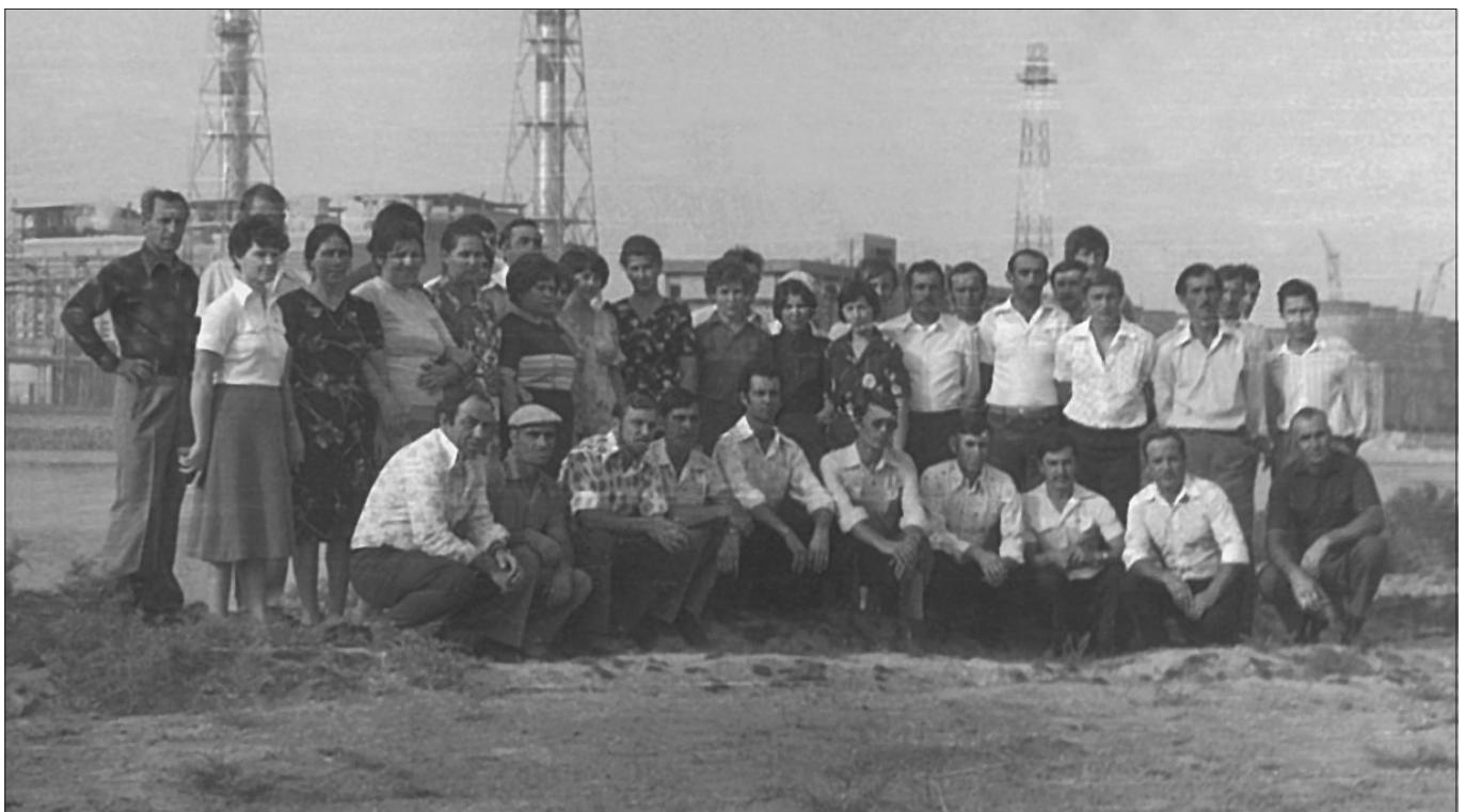
Будівельники СУ-2, СУ-3, СУ-1
