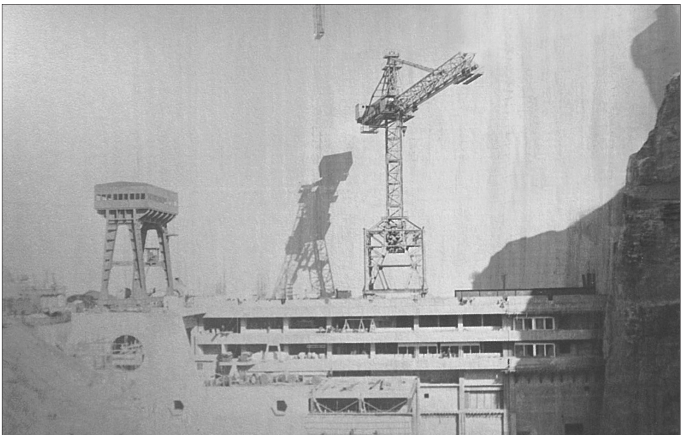
Будівництво ГЕС у Дакані
